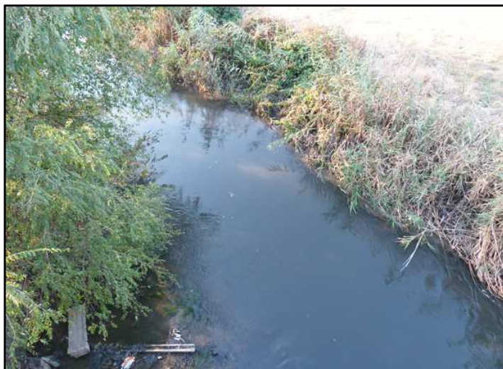
Imaginea 1 Canal construit de locuitori pentru transportul apelor uzate menajere spre râul Bîc, în aval de SEAU (Floreni)
